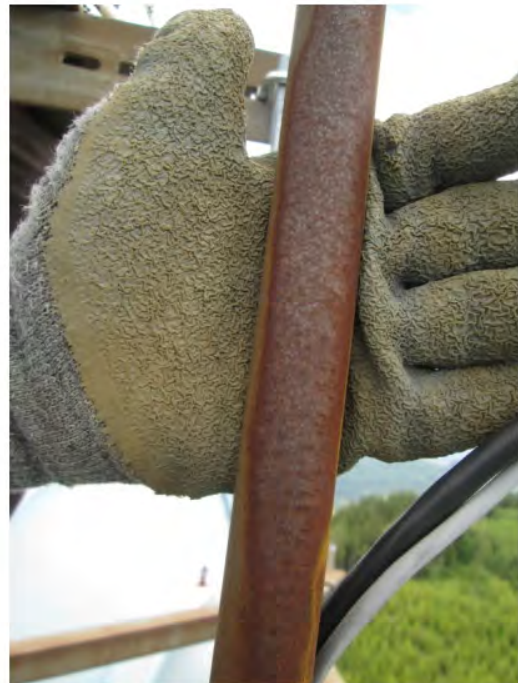
152 Peterman Lighting Conduit Corrosion
