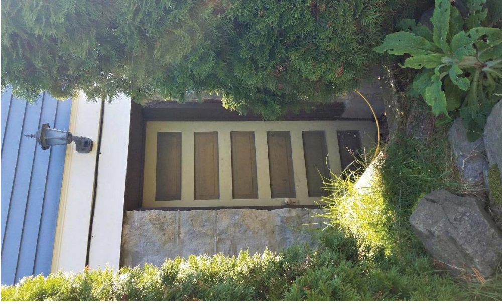
Original Basement Door - 2020
