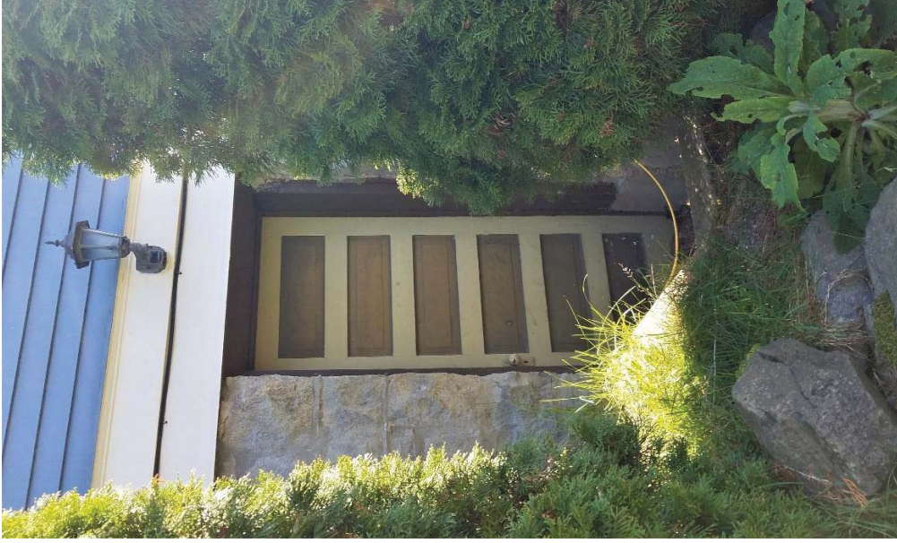
Original Basement Door - 2020
